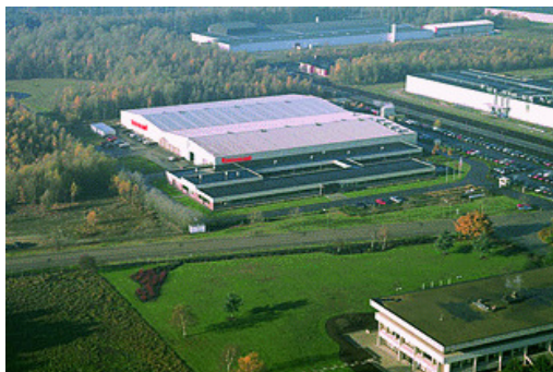
Plant 48 te Oevel (productie)
