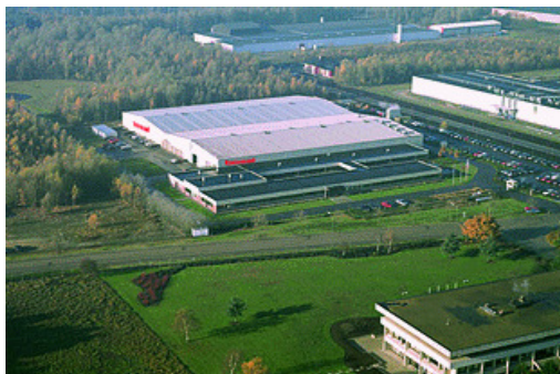
Plant 48 te Oevel (productie)
